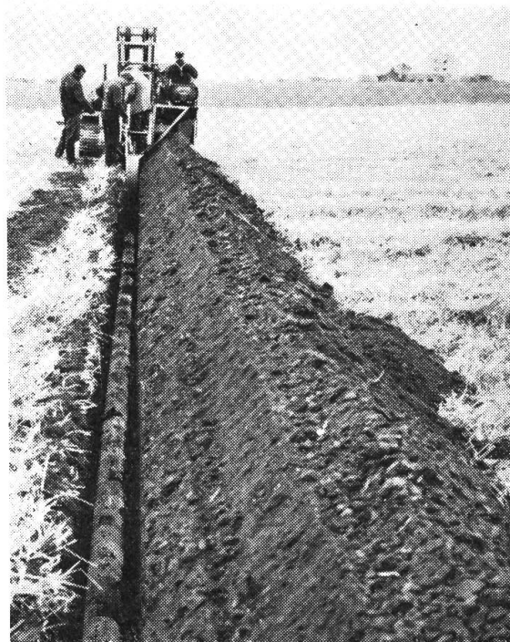
Abb. 2: Das Schürfrad der Grabenfräsmaschine kann mit 10 U/min angetrieben werden und zieht mit einer Geschwindigkeit von 12 bis 22 bzw. 30 cm breite und bis zu 142 cm tiefe Gräben.
