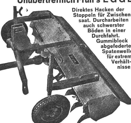
Direktes Hacken der Stoppeln für Zwischen-saat. Durcharbeiten auch schwerster Böden in einer Durchfahrt. Gummiblock abgefederete Spatenwelle für extreme Verhältnisse.
