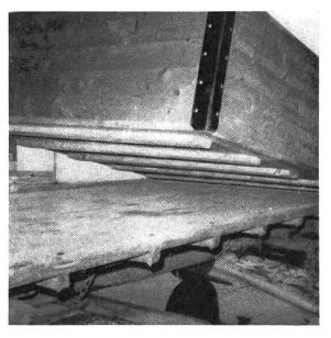
Fussleisten – grosse Stabilität – Verlängerung der Lebensdauer, Luftzirkulation unter dem Behälter möglich
