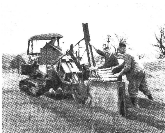
Die Grabenziehmaschine beim Aushub und gleichzeitigen Verlegen von PVC-Stangen.
