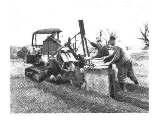
Die Grabenziehmaschine beim Aushub und gleichzeitigen Verlegen von PVC-Stangen.
