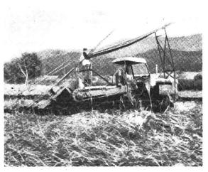
Die gleiche Maschine beim Ausheben der Erde und gleichzeitigen Verlegen von Tonrohren.
