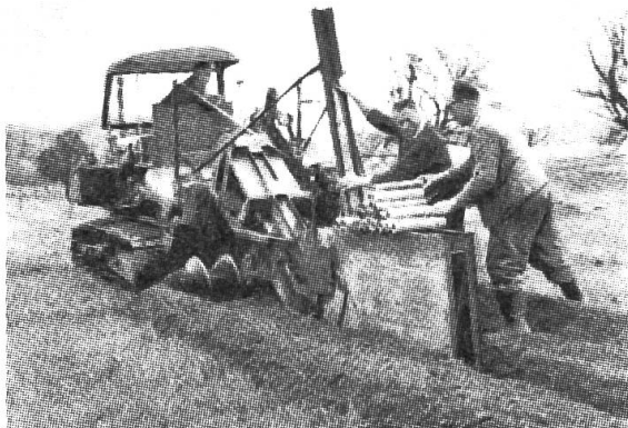
Die Grabenziehmaschine beim Aushub und gleichzeitigen Verlegen von PVC-Stangen.
