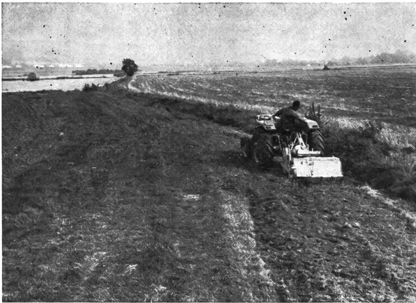
Abb. 2: Hinein in die Wildnis! Die Fräse lockert den humosen Boden, damit er mit Planierschild und Frontlader abgeräumt werden kann.
