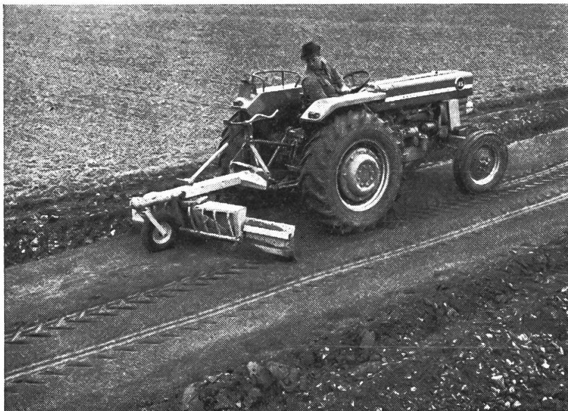
Abb. 6: Der letzte glättende Strich mit dem Heck-Planier- schild über die Ver- schleißschicht . . .
