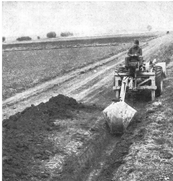
Abb. 4: Der Weg hat schon etwas Profil — das «Vorplanum» ist hergestellt. Jetzt wird erst einmal der Graben gemacht. Hier der Seitengraben auf der rechten Seite.
