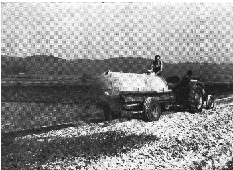
Abb. 3: Wasser marsch! Der Kalk ist ausgestreut, in Wasser gelöstes «Terrabind» wird aufgebracht, und das Ganze wird nachher mit der Fräse kräftig ge- mischt, damit die «Bodenstabilisierung» stattfinden kann.
