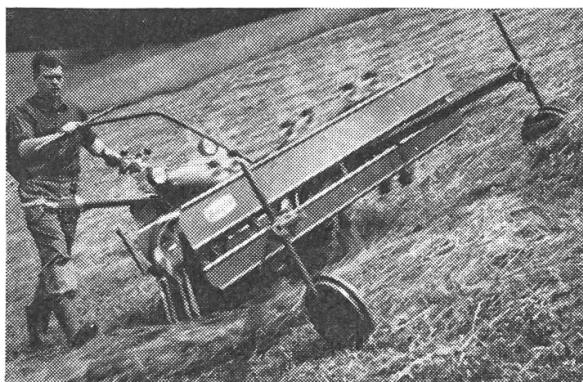
Der neue Rapid heuer ist speziell zum Anbau an den Motormäher Typ 505 gedacht. Seine niedere und sehr robuste Bauart, sowie die grosse Wendigkeit genügen den höchsten Ansprüchen im Berggebiet.
