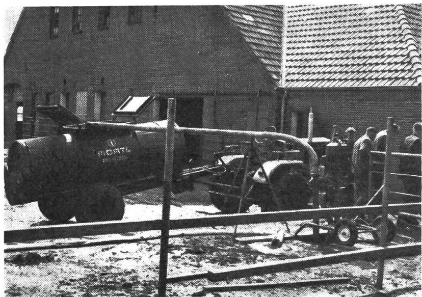
Abb. 1: Frontansicht eines alten Gebäudes, welches zu einem modernen Boxenlangstall umgebaut wurde. Im Vordergrund sehen wir den Laufhof und die maschinelle Ausstattung, bestehend aus Mixerpumpe und Schleuderfuss, zum Ausbringen der Gülle.
