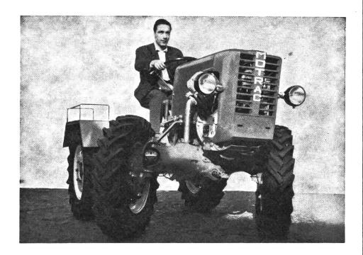
Der neue MOTRAC-VARIO wird Ihnen als Traktor und Transporter mit 22 PS oder 32 PS auch in nassem und ungünstigem Gelände ein zuverlässiger Helfer sein. Die einfache Bedienung der Synchronschaltung und der Vorteil: 4 treibende Räder sind Gold wert.
