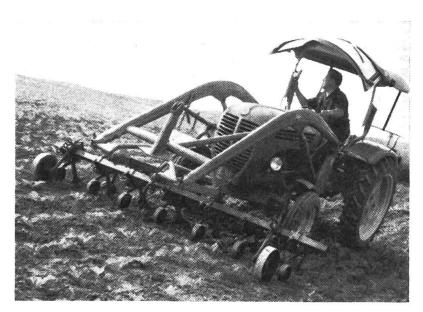
Das Frontladerhackgerät wurde besonders gern im Mais und Raps verwendet, da hier infolge der geringeren Empfindlichkeit der Pflanzen durch die Arbeitsgeschwindigkeit eine hohe Flächenleistung erreicht werden konnte. Naturgemäss muss beim Rübenhacken entsprechend langsamer gefahren werden.
