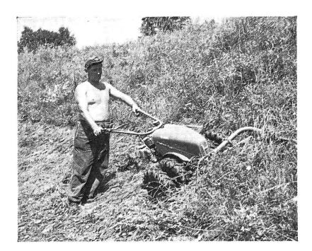
Abb. 5: Ein interessanter Motormäher mit einem Doppelmessermähwerk.
