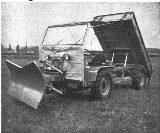
**Kipper und Schneepflug** ist die ideale Ergänzung des Merk-Pullax-Forst-Traktors zum Bau und Unterhalt der Strassen. Dank dem 4-Rad-Antrieb und dem niederen Schwerpunkt schleppt er die schwersten Stämme mühelos!
