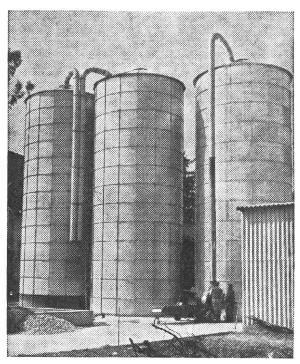
Silobatterie MARYSON à 3 Silos von je 220 m³ Inhalt mit Obenentnahmefräsen Schönberger, bei Herrn André Schertenleib in Marin NE.
