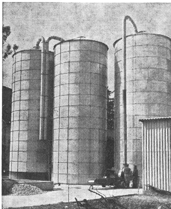
Silobatterie MARYSON à 3 Silos von je 220 m 3 Inhalt mit Obenentnahmefräsen Schönberger, bei Herrn André Schertenleib in Marin NE.
