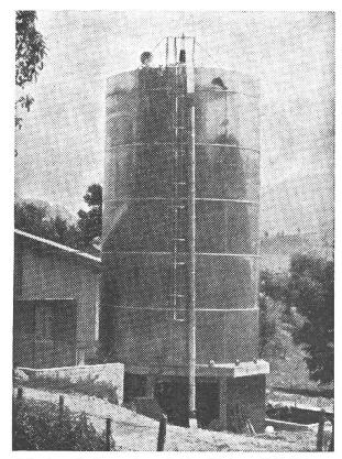
Vollautomatischer und gasdichter Siloturm ALU-FSA von 330 m³, bei Herrn Paul Morard in **Le Bry FR.**
