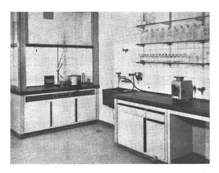
Ein chemisches Laboratorium mit Kapelle (links), Trog und Labortisch (rechts). Boden, Tische und dahinter liegende Wände sind mit Keramik-Plättli belegt.
