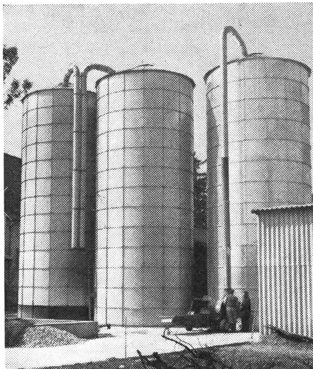
Silobatterie MARYSON à 3 Silos von je 220 m 3 Inhalt mit Obenentnahmefräsen Schönberger, bei Herrn André Schertenleib in Marin NE.
