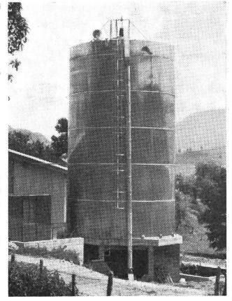
Vollautomatischer und gasdichter Siloturm ALU-FSA von 330 m³ bei Herrn Paul Morard, in Le Bry FR.
