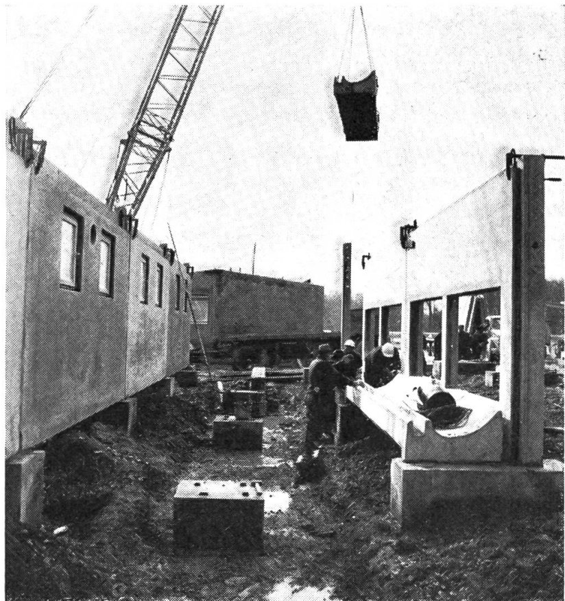
Abb. 1: Element reiht sich an Element. Flüssig geht die Montage vor sich.
