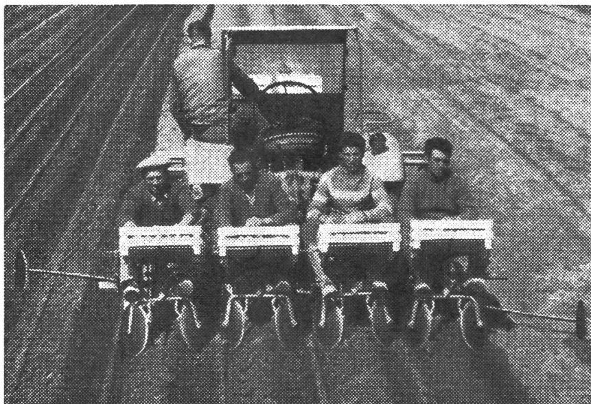
Kartoffelsetzen 4-reihig mit unseren Patent-Setzautomaten.
