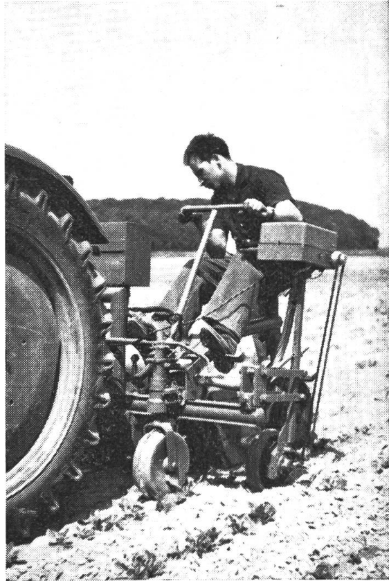
Abb. 3: Neben dem Feinsteuermann der Elektronikasten. Ein Zahnband überträgt von einem Bodenrad den Vorschub zu ihm hin... Natürlich kann man auf den Feinsteuermann verzichten, wenn man mit der Maschine einmal eingearbeitet ist.
