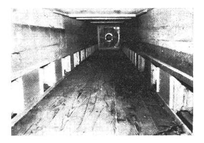
Bei den Austrittsöffnungen werden meist Luftklappen oder Schieber angebracht. Eine exakte Dosierung der Luftmenge ist jedoch nur mit Schiebern möglich, weil damit die Oeffnungen je nach Bedarf mehr oder weniger geschlossen werden können. Die Klappen sind entweder offen oder geschlossen. Eine Zwischenstellung gibt es in der Regel nicht. In der Praxis werden oft mehrere kleine Klappen angebracht, womit auch eine gewisse Regulierung erreicht werden kann.
