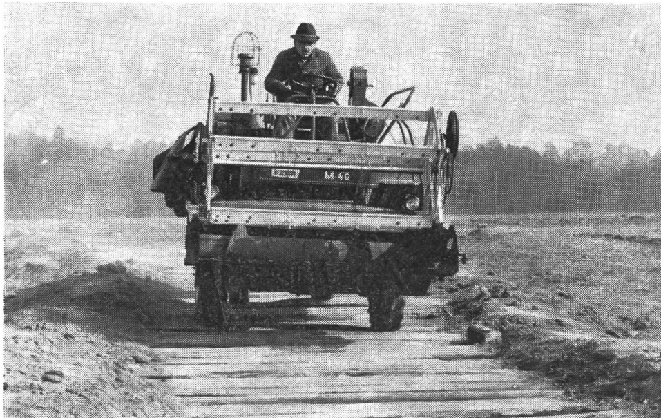
Mähdrescherprüfung auf einer Hindernisstrecke.
