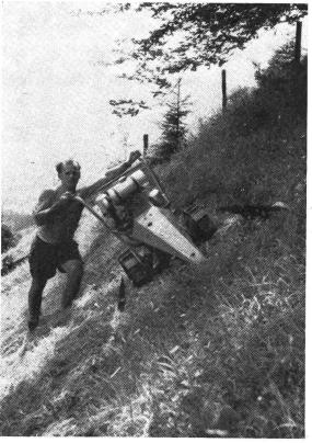
Die Vorderlastigkeit des Mähers (der Balken liegt mit rund  $25\,^{0}/_{0}$  seines Eigengewichtes auf dem Boden auf) hat sich bis zu einer Hangneigung von rund  $6\,0\,^{0}/_{0}$  gut bewährt. Die Bedienungsperson konnte sich an den Sterzen etwas anhalten ohne dadurch den Balken vom Bo-
