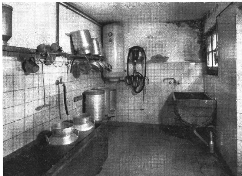
Abb. 10: Hier wurden der Lüftung und Isolation nicht genügend Aufmerksamkeit geschenkt. Wandplatten beheben elementare Mängel nicht.
