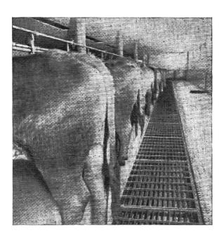
Abb. 6: Schwemmentmistung mit Gitterrost (Rückstauverfahren)
