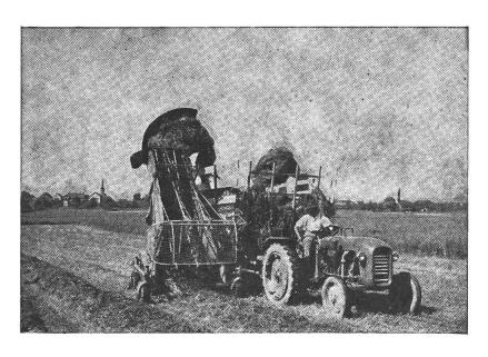
Abb. 1: Aufnahme von Welkfutter mit dem Seitenlader
