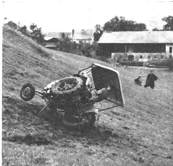
Abb. 3: Traktor mit Sturzverdeck und aufgesetzter Strohuppe beim Sturz. Verdeck und Puppe haben keinen Schaden genommen, obwohl sich dieser Traktor 3\frac{1}{2} mal überschlug.
