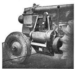
Automatische Seilführung. Auf die meisten Marken-Traktoren montierbar.
