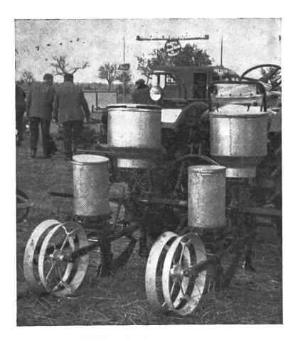
Abb. 3: Amerikanische Einzelkornsäapparate mit horizontal rotierenden Zellenrädern. Vorne gegen den Traktor sind zwei Düngerstreugeräte angebracht.
