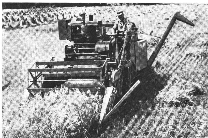
Bei der Verwendung eines Tankes zur Körnerbergung kann der Mähdrescher durch eine einzige Person bedient werden.
