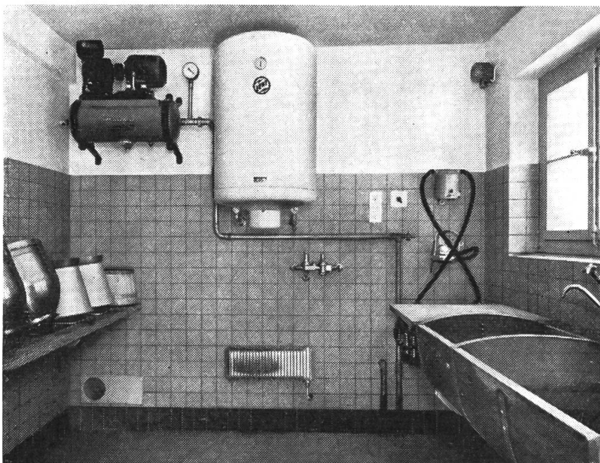
Ein Reinigungs- und Aufbewahrungsraum mit Heisswasserboiler und zweiteiligem Waschtrog ist für die Sauberhaltung der Melkmaschine unentbehrlich.
