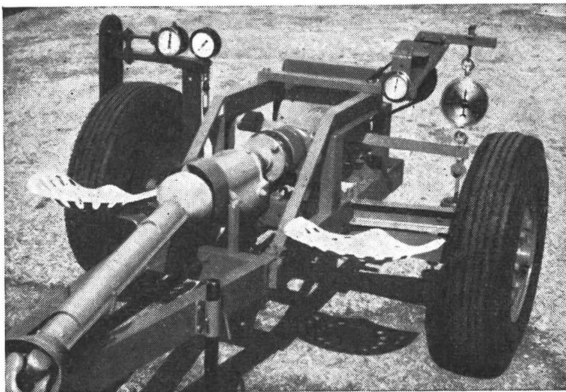
Das Leistungsmessgerät vom Traktor aus gesehen. Vorn auf dem Bild erkennt man die Gelenkwelle mit Schutz. Die Messinstrumente von links nach rechts sind:
