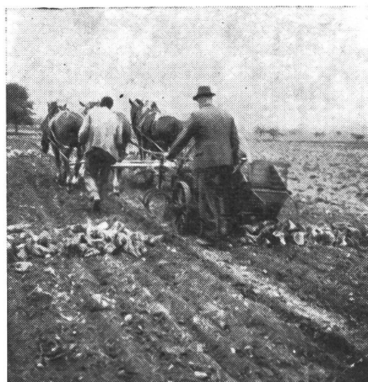
Abb. 4: Vorratsroder mit Rübenablege in Querschwaden
