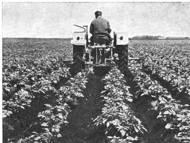
Abb. 2: Tragtraktor mit Zwischenachsgerät beim Kartoffelhäufeln
