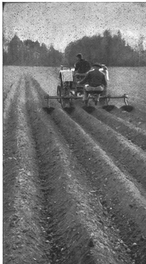
**Vielfachgerät Haruwy** bei der Häufelarbeit. Selbst bei einem Arbeitstempo von 12 km/h ist die Kartoffelfurche locker und die Häufelarbeit einwandfrei. Gleichzeitiges lockern mit Spurlockerer.
