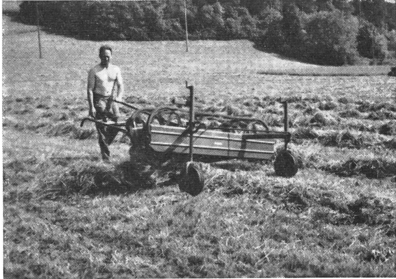
Abb. 6: Für das Schwadenzetten ist Schrägstellung und grosse Fahrgeschwin- digkeit erforderlich
