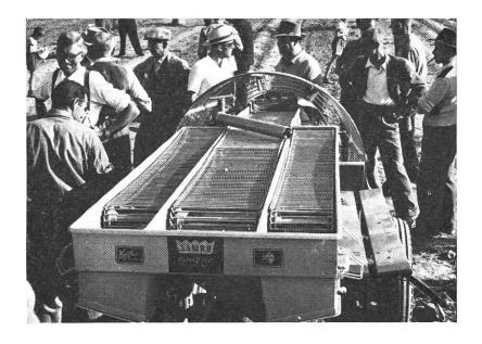
entweder die Kartoffeln aus dem Beigemenge oder umgekehrt herausgelesen. Vom Verleseband gelangen dann die verlesenen Kartoffeln zur Absackung. Zum Verlesen sind für das Arbeitspersonal beidseitig Sitzplätze vorhanden. Das umschaltbare 3-Gangwechselgetriebe ermöglicht eine weitgehende Anpassung an spezielle Bodenverhältnisse.
