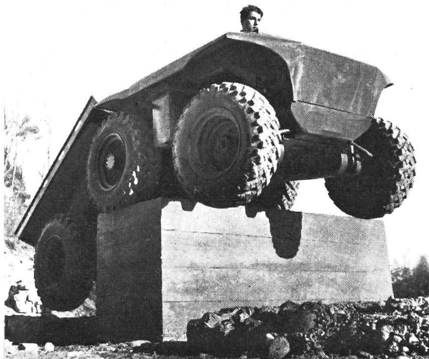
Das «Flex-Trac»-Prinzip kann bei verschiedenen grossen Fahrzeugtypen Anwendung finden. Der uns vorgeführte Prototyp weist folgende Daten auf: Gesamtlänge etwas über 4 m, Gesamtgewicht 3 t, Antrieb durch VW-Motor (es kann auch jeder andere Motor eingebaut werden), 6 Räder mit gewöhnlicher Geländepneubereifung. Erwähnen möchten wir noch, dass auch Varianten mit mehr als 6 Rädern vorgesehen sind.
