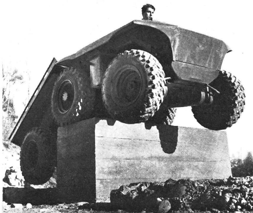
Das «Flex-Trac»-Prinzip kann bei verschiedenen grossen Fahrzeugtypen Anwendung finden. Der uns vorgeführte Prototyp weist folgende Daten auf: Gesamtlänge etwas über 4 m, Gesamtgewicht 3 t, Antrieb durch VW-Motor (es kann auch jeder andere Motor eingebaut werden), 6 Räder mit gewöhnlicher Geländepneubereifung. Erwähnen möchten wir noch, dass auch Varianten mit mehr als 6 Rädern vorgesehen sind.
