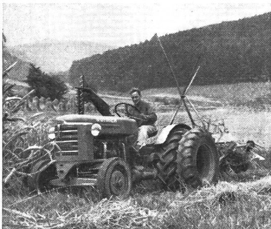
Abb. 7: Traktor mit Doppelbereifung beim Ziehen des Bindemähers. Keine Beschädigung der Kleeinsaat.
