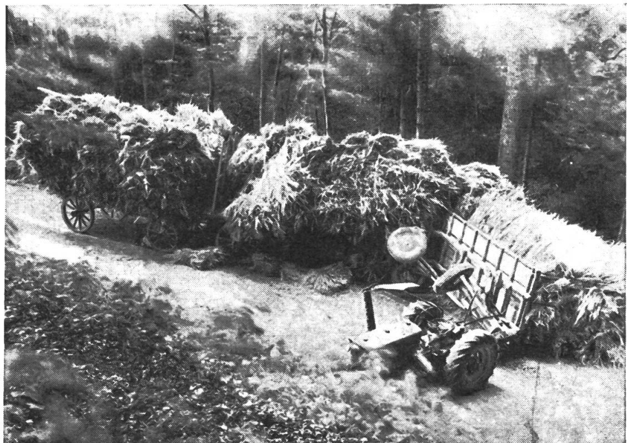
Abb. 8: Die Folgen eines überladenen, unge- nügen gebremsten Traktorzuges.
