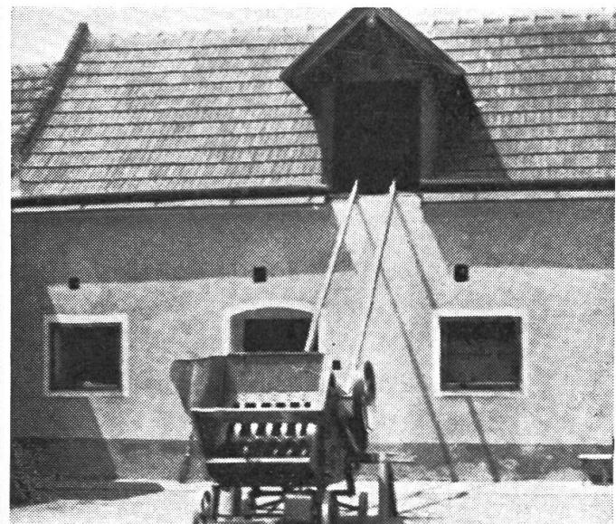
**Zum Hochschieben von Heu durch die Ballenpresse** genügen bei einer geraden und kurzen Förderstrecke zwei Rundholzstangen. Ist die Förderbahn länger oder auch etwas gekrümmmt, müssen weitere Stangen angebracht werden, um das seitliche Ausbrechen von Ballen zu verhindern.
