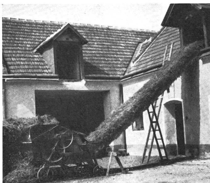
**Statt Anschaffung von immer mehr Spezialmaschinen** ist stets grundsätzlich danach zu trachten, bereits vorhandene Maschinen noch anderen Zwecken dienstbar zu machen. So z. B. kann es unter geeigneten baulichen Voraussetzungen zweckmäßig sein, eine Strohpresse zum Abladen und Einlagern des Heues zu verwenden. Sie ersetzt dabei am ehesten die Arbeit eines Höhenförderers, bietet aber den zusätzlichen Vorteil der Ballenformung und Pressung.
