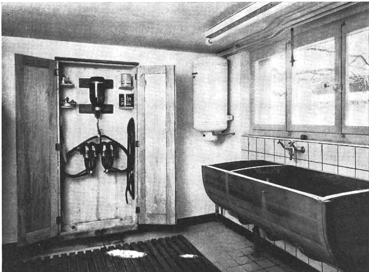
Abb. 8: Bei Anschaffung einer Melkmaschine soll ein geeigneter Raum mit Warmwasserboiler und zweiteiligem Waschtrog zur Verfügung stehen.
