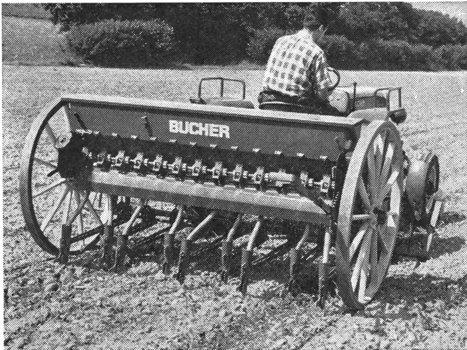
Versuche mit der Bucher-Sämaschine zeigten, dass jede in Betracht kommende Menge Harnstoff «Ems» (von 15—420 kg pro Hektare) sehr exakt eingestellt und ausgestreut werden kann.
