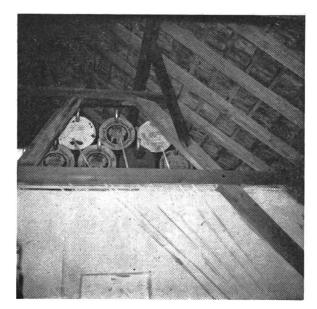
Abb. 8: Maschinenecke im Oelraum: Kompressor und Waschpumpen. Ganz rechts ist die Verbindungstüre zum Waschraum erkennbar.
