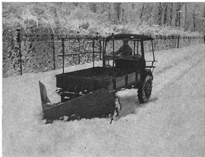
Abb. 3: Der Alldog mit Schneepflug und Sandstreuer
