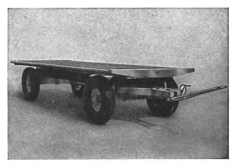
«WM»-Pneuwagen, 1,5—5 Tonnen Nutzlast, rostfreie Ganzmetallkonstruktion
