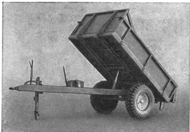
Universal-Anhänger als Kipper 1,5 m 3 Inhalt, mit abgelegter Front- und Rückwand als Heu- und Graswagen verwendbar.
