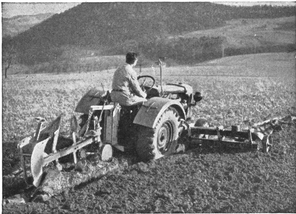
**Ott-Anbaupflüge** mit Stützrädern leisten in der Ebene und am Hang beste Arbeit. Sie sind während der Arbeit weitgehend unabhängig von den Bewegungen des Traktors und in der Arbeitsleistung deshalb den Selbstthalterpflügen am ähnlichsten. Verlangen Sie unverbindliche Offerten für Anbaupflüge und Anbaukultivatoren.
