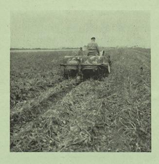
Abb. 6: Krautschläger als Anbaugerät für Traktoren.
