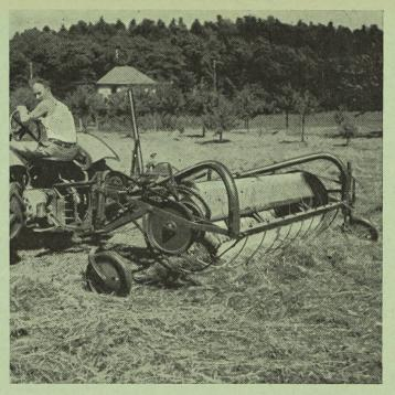
Abb. 4a: Trommelschwadenrechen beim Lüften.
