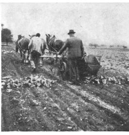
Abb. 6 Vorratsroder mit Rübenablage am Querschwaden.
