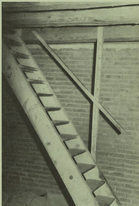
Abb. 6: Wo die Erstellung eines Geländers nicht gut möglich ist, muss wenigstens ein Handlauf angebracht werden.
