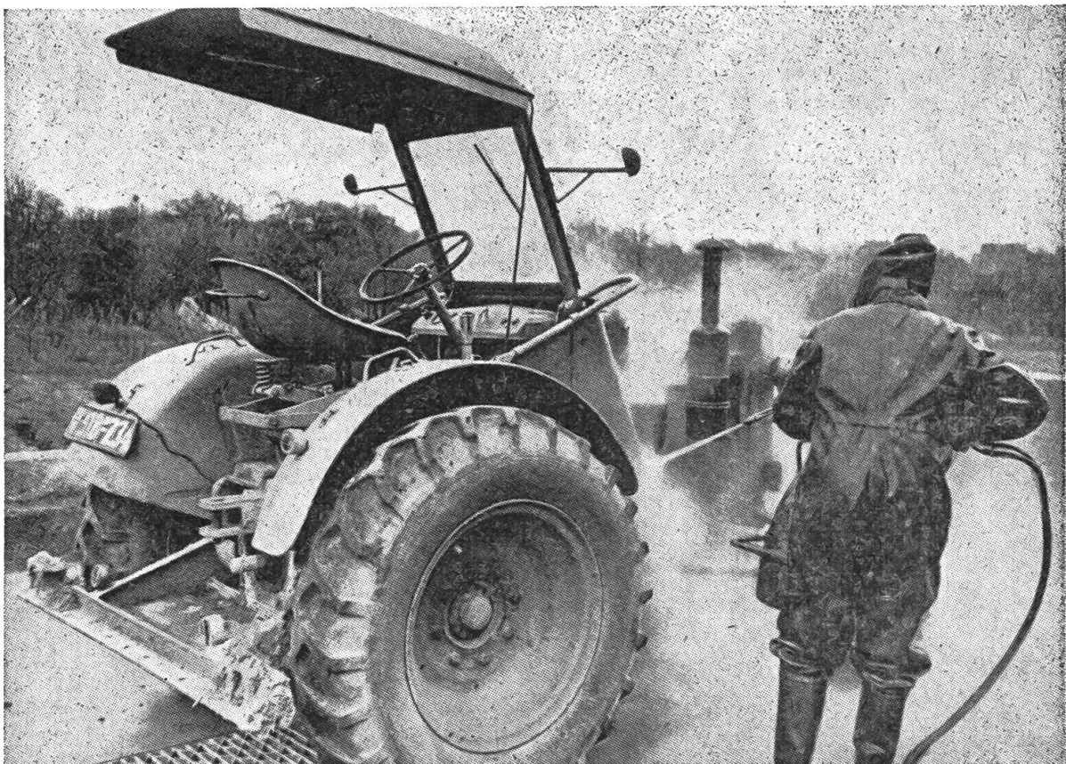
Heisses Wasser, hoher Druck und ein Reinigungsmittel machen den Traktor in 30 bis 40 Minuten blitzsauber
