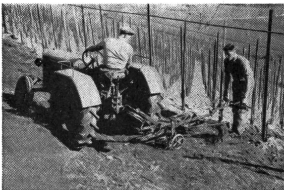
Abb. 13: Der gleiche Traktor mit Seilwinde Jaga von J. Gasser, Hallau und Rebergpflug.
